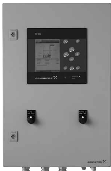
Rys. 38 Szafka sterownicza Sterowników Dedykowanych
